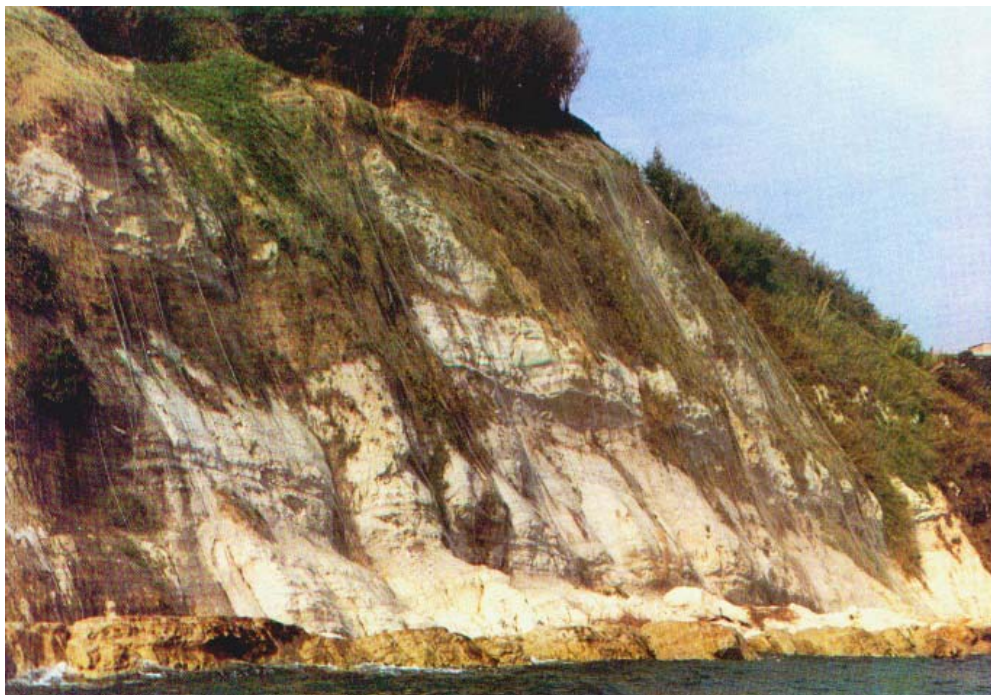
figura 15: Sistemazione di falesie con reti metalliche
