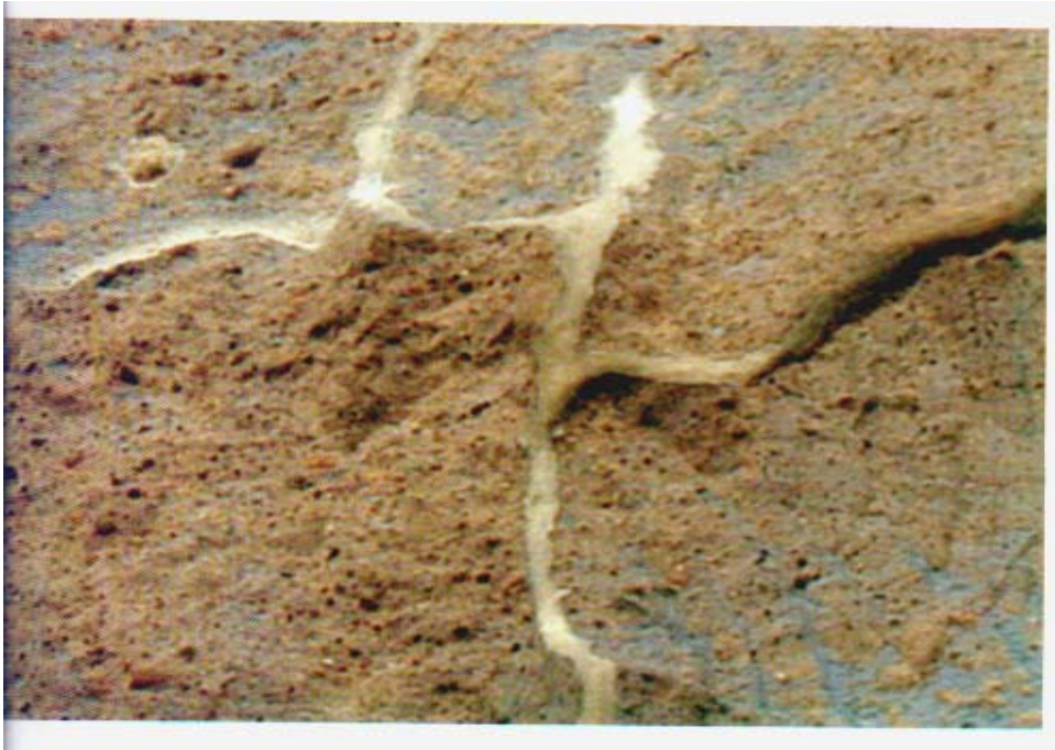
figura 22: Trattamento con miscele sigillanti lungo fratture
