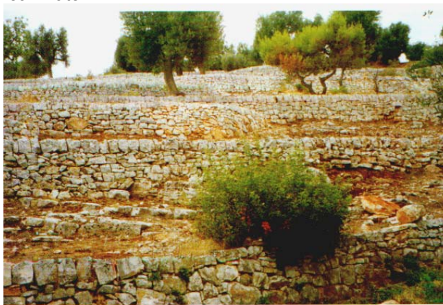
figura 5: Gradonatura di un versante con murature di pietrame a secco
