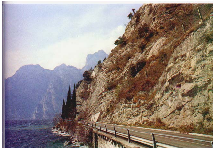
figura 21: Interventi con barriere paramassi
