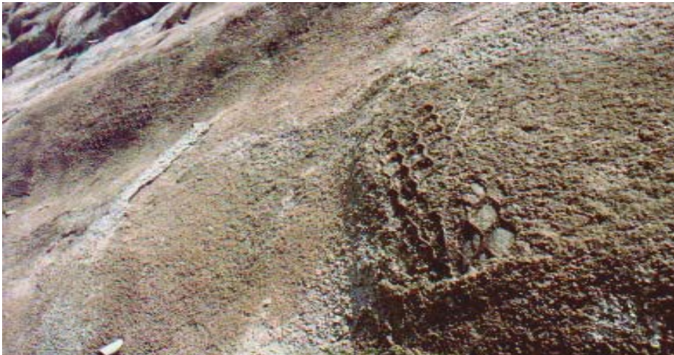
figura 11: Intervento con spritz beton
