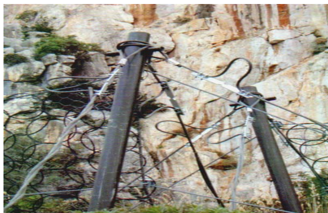
figura 19: Barriera paramassi elastica
